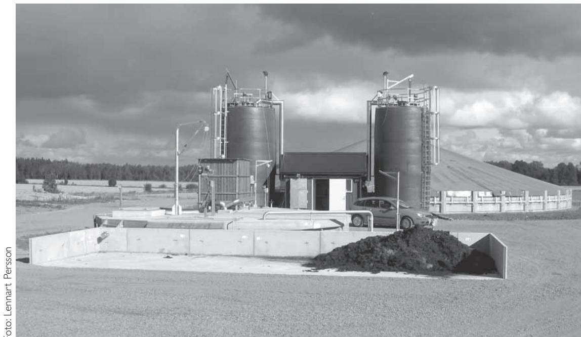
Bild 8. Norrtälje. Anläggningen i Norrtälje har semi-kontinuerlig drift. Den bygger på samma teknik som anläggningen i Eskilstuna, men har två parallella reaktorer och högre kapacitet.
