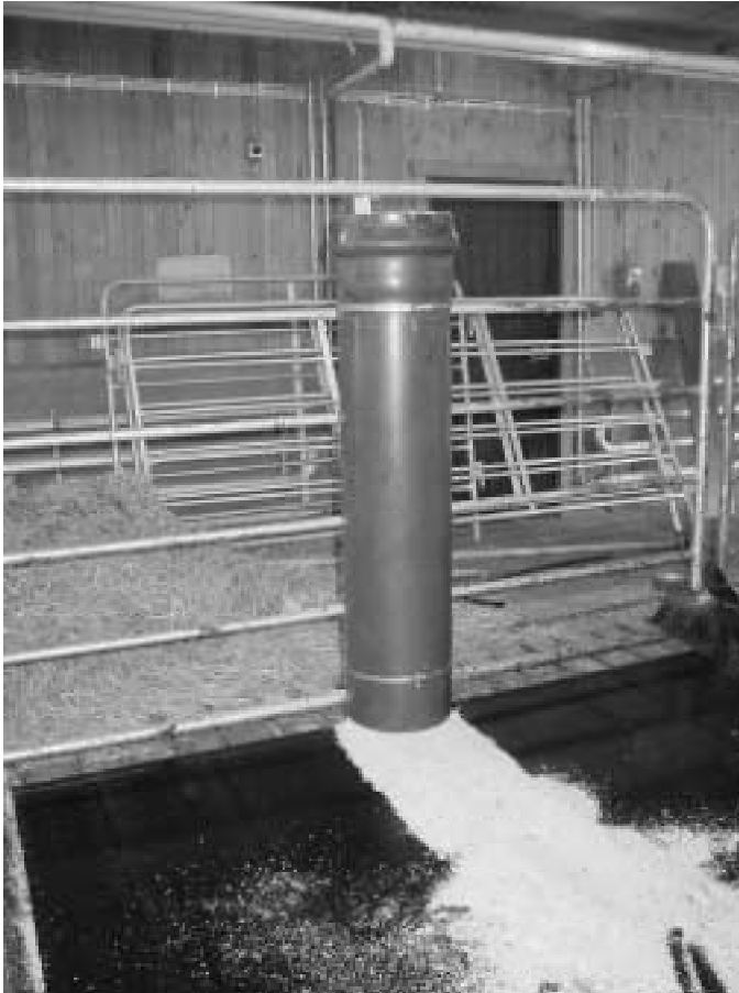
Figur 1. Automatisk strötilförsel genom ett 250 mm rör monterat 5 cm över mattan i boxens bakgrund.
