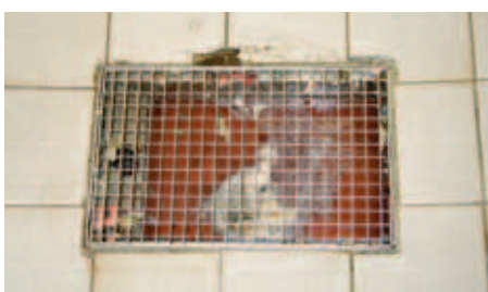
Bild 11a. En nackdel med klinker är hållbarheten, då plattorna kan spricka. I dag finns andra alternativ till klinker som har bra hållbarhet, är hygieniskt och lättstädad.
