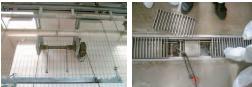
Bild 13a och b. Hudavdragare med fastsättning i golv.
