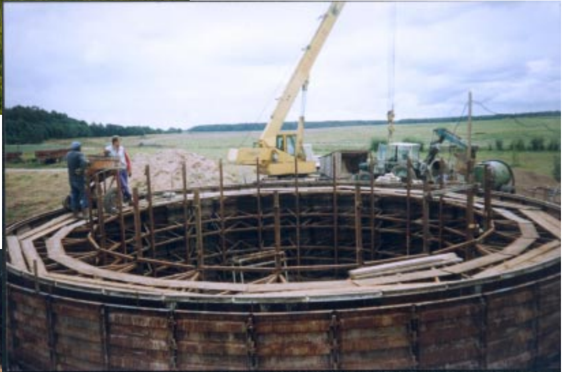
Bild 6 (ovan). Byggnation av en gödselbehållare under JTI:s projekt, för att utöka lagringskapaciteten av stallgödsel på demonstrationsgården Melupite, Lettland.
