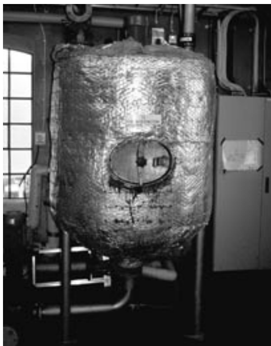
Bild 5. Hygieniseringstank på Nynäs gård. Värmebehandlingen sker satsvis vid 70°C.
