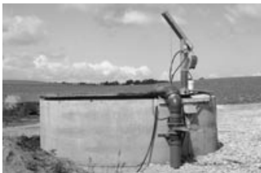
Bild 2. Behållare. Fasta och flytande substrat blandas här till en pumpbar lösning.
